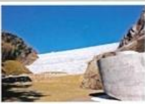
29 南相木ダム 石灰岩を積み上げて造ったロックフィルダム
