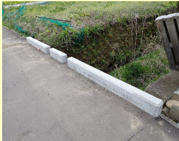
写真. 地覆補修例(神殿橋)
