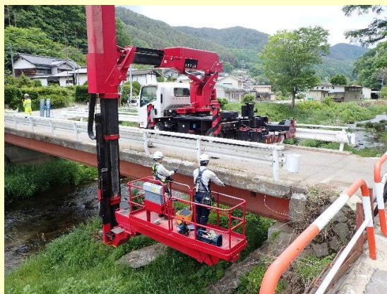
橋梁点検車による近接目視
