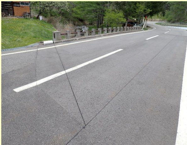
写真. 橋面補修例(三川橋)
