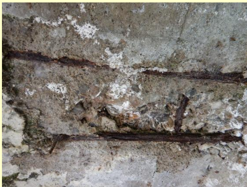
鉄筋コンクリート橋の劣化
