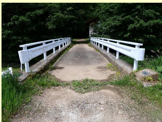
健全度 I : 土岩1号橋
