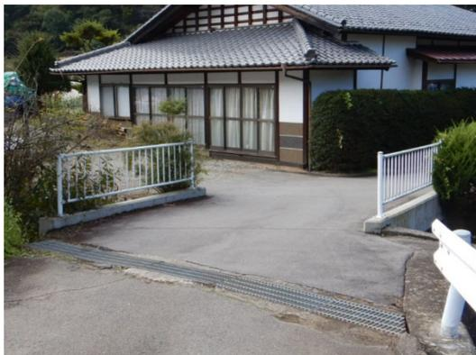
写真3. 高欄補修例
