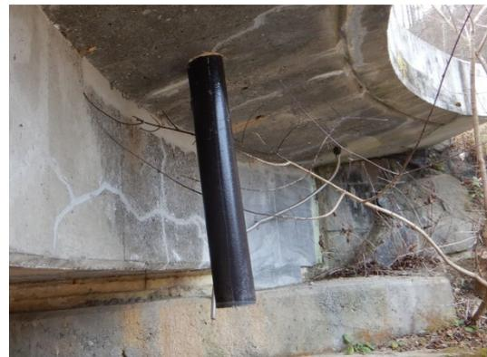
写真4. 排水装置補修例
