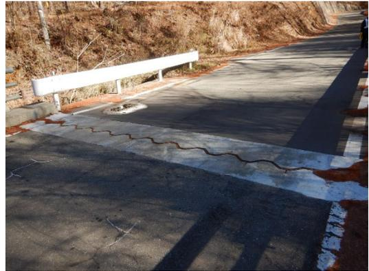
写真2. 伸縮装置補修例
