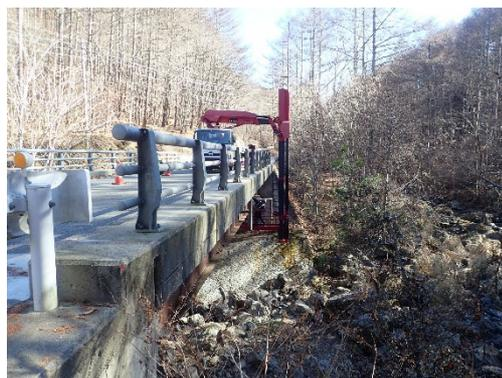
写真 2. 橋梁点検車による点検
